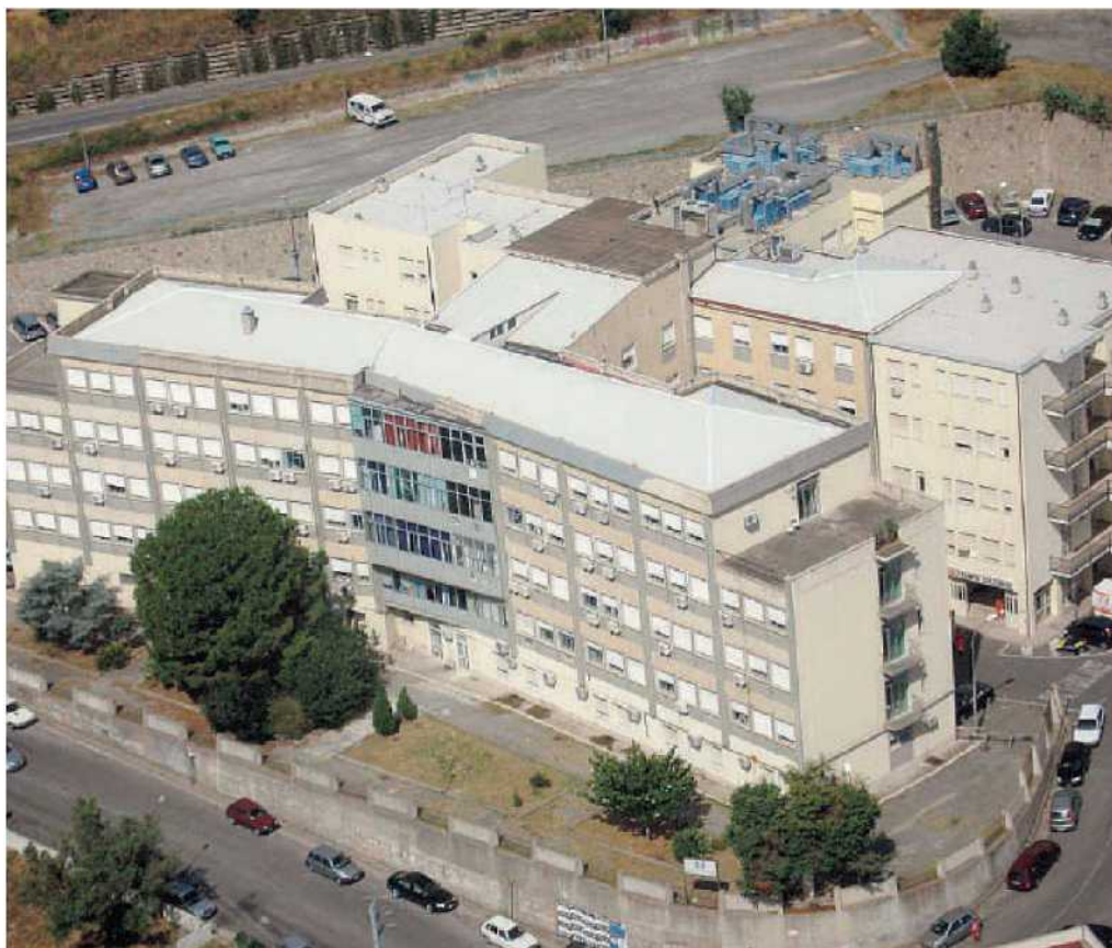
La struttura ospedaliera di Soverato presto potrebbe essere trasformata in una sorta di day hospital
