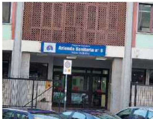
L'ingresso della sede dell'Azienda sanitaria provinciale
