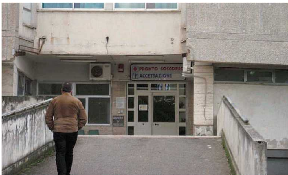
L'ospedale di Tropea è classificato come generale ma i servizi non sono adeguati
