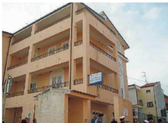
L'immobile divenuto nuova sede della postazione di emergenza del "118"
