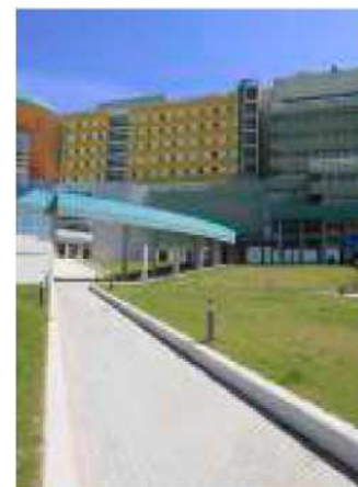
La sede di Fondazione Campanella
